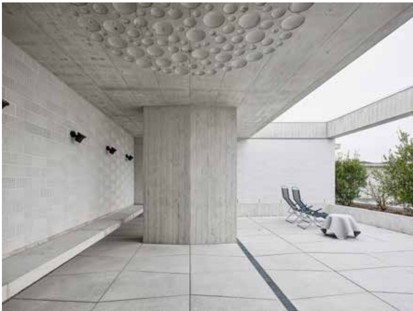
Das Lighthouse hat hier ein neues, grösseres Zuhause gefunden. Baulich erkennbar ist es an der wiederkehrenden Rundform. Im Palliativzentrum verbringen Menschen ihre letzte Lebensphase in einem würdigen Umfeld. Besonders geschätzt wird die halbdgedeckte Terrasse.
